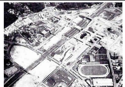
開業時の新百合ヶ丘駅周辺。左上の弓なりの部分に旧線があった(小田急電鉄広報『コミュニケート小田急』No.40、【部分】)
