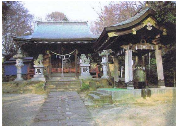
琴平神社旧本殿 平成19年6月火災により焼失
