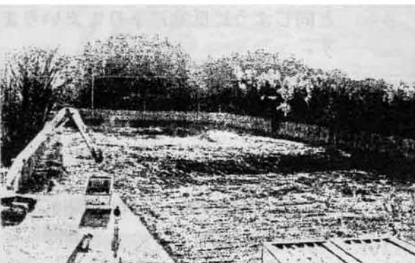
旧校舎解体後の更地
