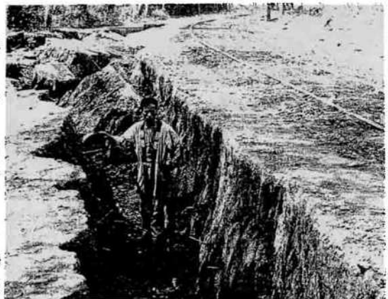
(川崎区伊勢佐木町の地割れ)
