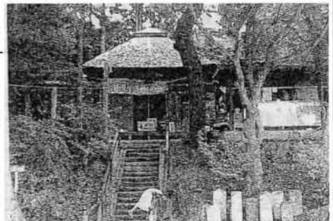
(鎌原観音堂二手前の階段の下にさらに35段が発見された)
